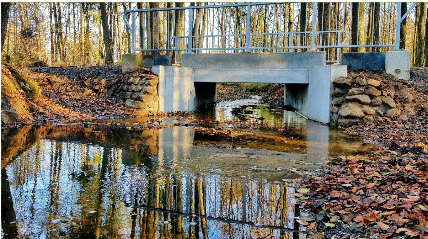
Abbildung 25: Neubau einer Brücke als Ersatz eines engen Durchlasses des Wambaches als Maßnahme zur Förderung der Durchgängigkeit von Makrozoobenthos und Fischen in Mülheim-Saarn (Foto: Renate Fuchs 2021).
